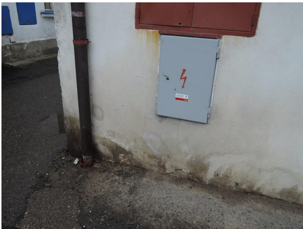
Foto č. 7 – Pohled na východní část fasády – plíseň na zdivu
