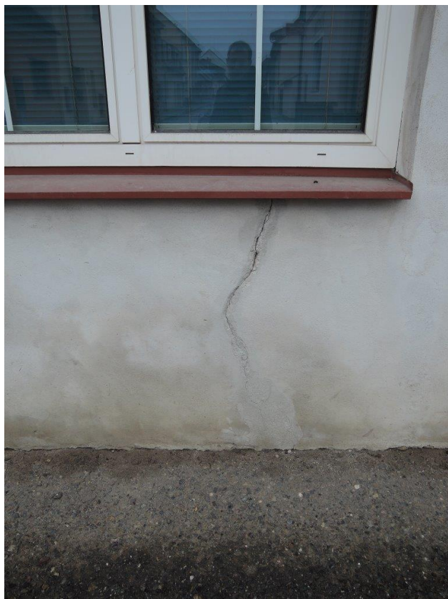
Foto č. 6 – Pohled na východní část fasády – trhlina pod oknem hl. 4 mm (trhlina dle majitele objektu se nevyskytuje ve zdivu, pouze v omítce)
