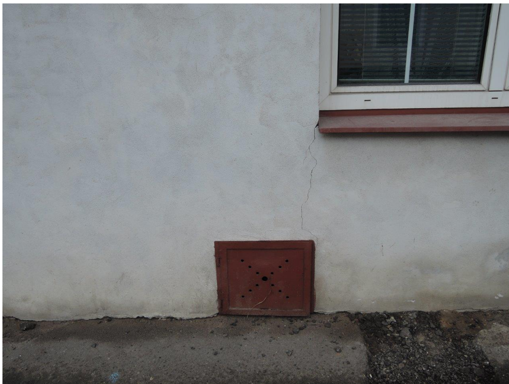
Foto č. 3 – Pohled na východní část fasády – trhlina od dveří ke spodnímu rohu okna
