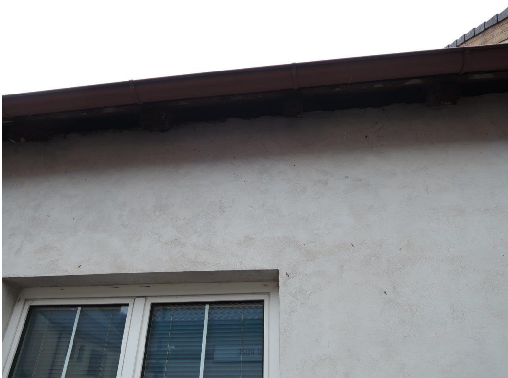
Foto č. 2 – Pohled na východní část fasády – trhlina od rohu okna směrem ke střeše
