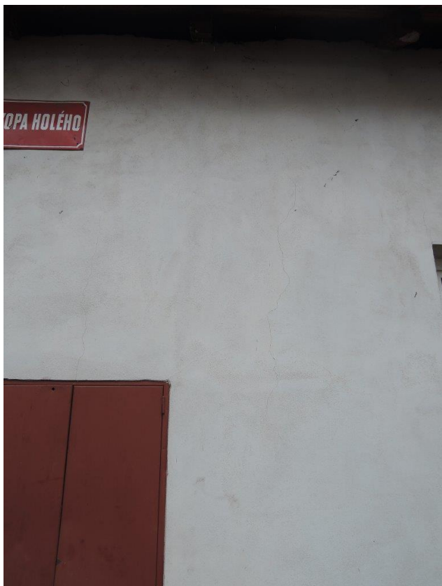
Foto č. 8, 9 – Pohled na východní část fasády – trhliny v omítce
