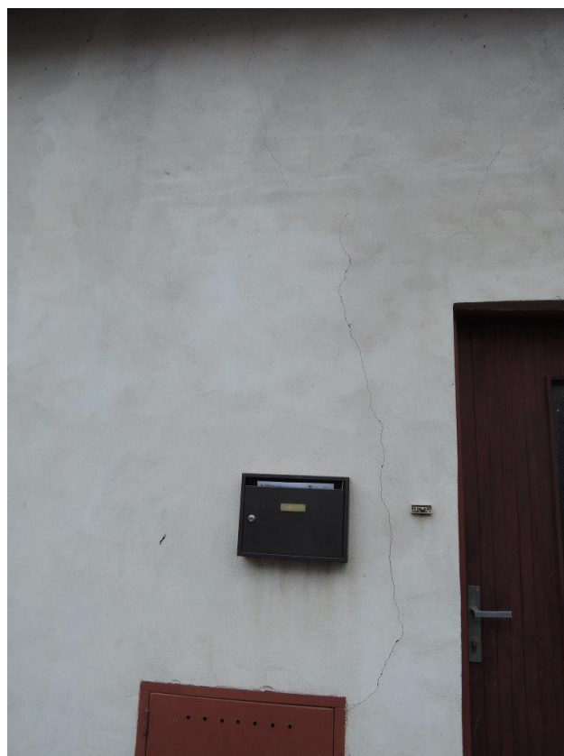
Foto č. 5 – Pohled na východní část fasády – trhliny vedle vstupních dveří
