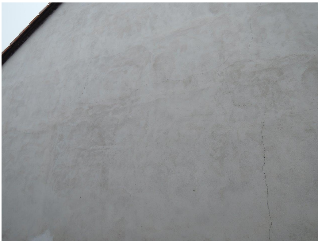
Foto č. 12 – Pohled na jižní část fasády – trhliny v omítce
