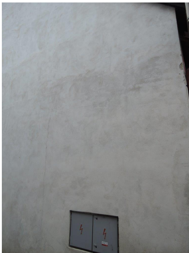
Foto č. 10 – Pohled na jižní část fasády – větší trhliny v omítce
