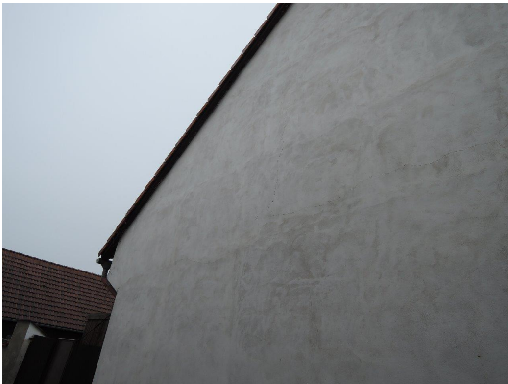
Foto č. 11 – Pohled na jižní část fasády – trhliny v omítce
